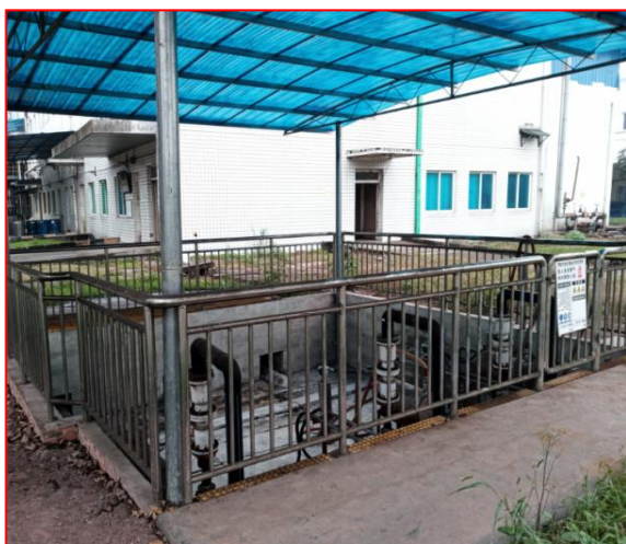
原料药二车间 15m 3 废水收集池（共用）
