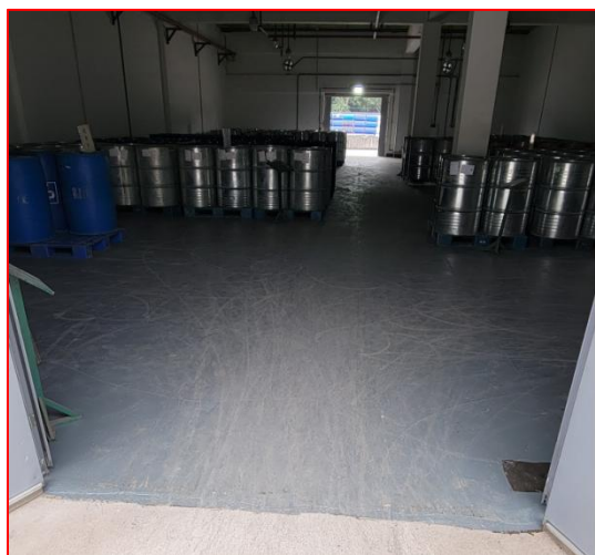
原料药库房（液体物料）地面防渗
