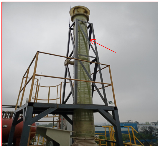
新增加氢间散排废气排气筒（新增） （15m、直径 0.35m）
