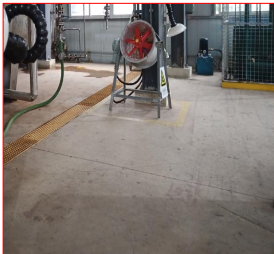
加氢间（反应釜底）地面防渗
