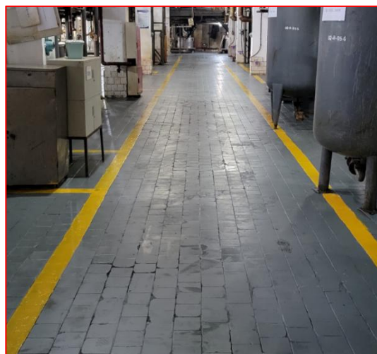
原料药二车间 地面防渗
