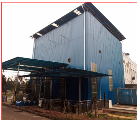
原料药三车间东侧高浓、高盐废水预处理装置（共用）
