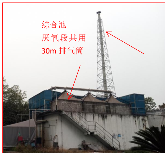
污水处理综合池废水集气罩（共用）
