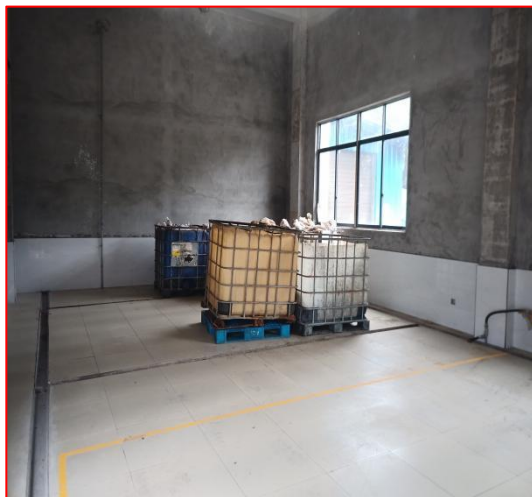
新增危废暂存间 地面防渗
