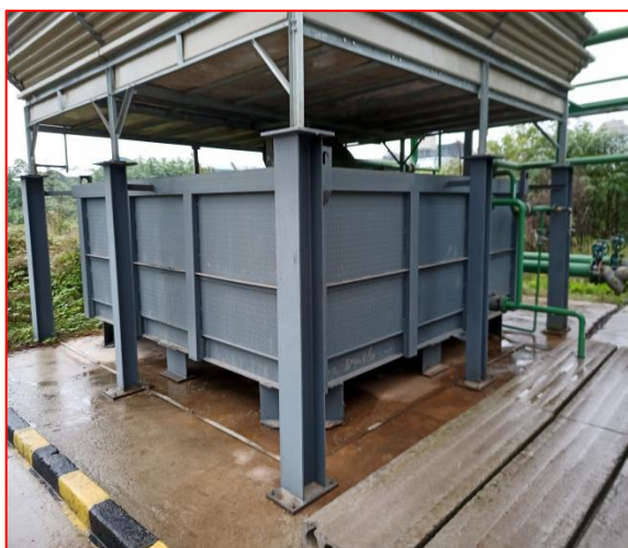
单独设置的加氢间旁循环水池
