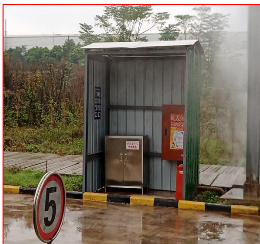
加氢间旁应急措施 (消防器材)
