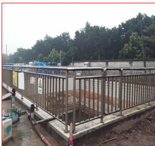
全厂应急事故池 (1#, 500m 3 )
